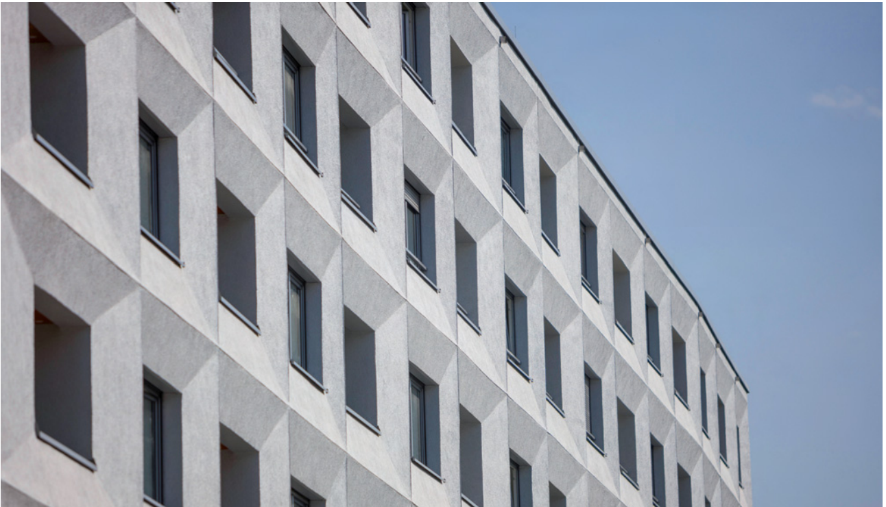
Mehrfamilienhaus in Bielefeld, Adomako Architekten (Paderborn), Sandstein
